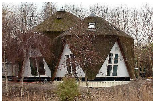
Rieten daken hebben meer bescherming nodig dan vroeger. FOTO: DIJKSTRA
