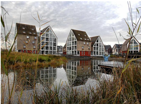
Zelfs appartementengebouwen kunnen tegenwoordig met riet gedekt worden. Zoals hier in Nunspeet. FOTO: ALDO ALLESSIE
