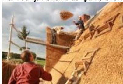
Rietdekkers van de firma Pape aan het werk op het dak van een villa in Gaanderen
